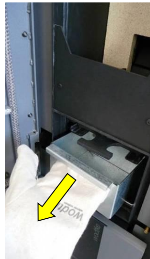
Abb. 70: Aschelade entfernen
