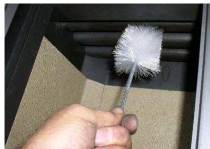
Abb. 39: Reinigung Wärmetauscher
