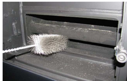
Abb. 37: Reinigung Wärmetauscher
