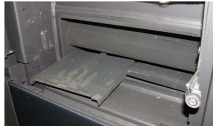
Abb. 36: Entfernen Stahlblech Umlenkungen
