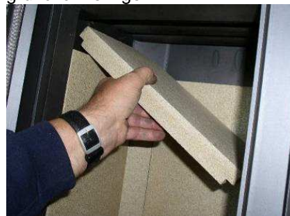
Abb. 38: Ausbau Umlenkplatte
