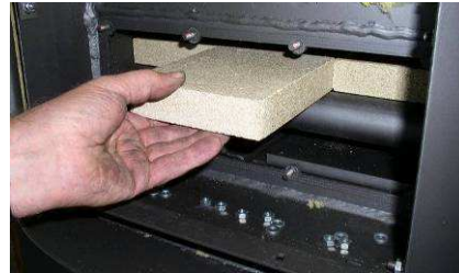
Abb. 35: Entfernen Vermiculiteumlenkungen
