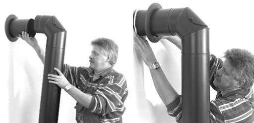
Abb. 5: Anschluss Rauchrohr am Schornstein
