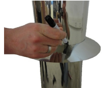
3. Position des Wetterkragens an Abgasanlage anzeichnen
