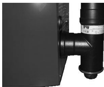
Fig. 82 - Reinigung des Rauchgaskanals
